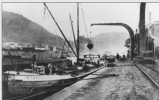
Nahore: Motorová loď OTAKAR v překladštil. (z publikace Po Vltavě a po Labi až do Hamburku, sbírka MC, m003072). Dole: Stavba motorové nákladní lodi OTAKAR pro ČPSL v roce 1929 (sbírka MC, m003075).
