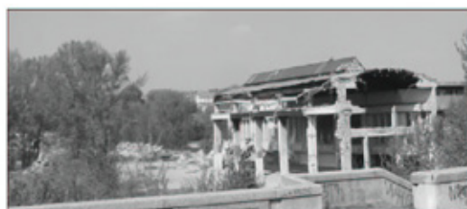
Bourání výrobních hal loděnice v Praze-Libni po ukončení jejího provozu v roce 1994 znamenalo i viditelný konec nejdéle pracujícího podniku, který ing. L. Platovský založil (foto M. Příkrýl 2010, mc 071317)
