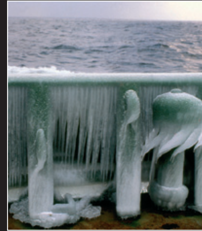
Namrzlé zábradlí - m/s Radhošť, 5. 2. 1986, plavba Kotka - New Orleans
